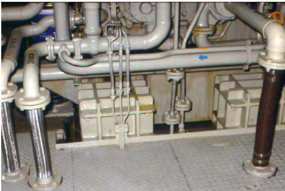
تصویر ۹-۹- استفاده از اتصالات انعطاف پذیر در تأسیسات مکانیکی
