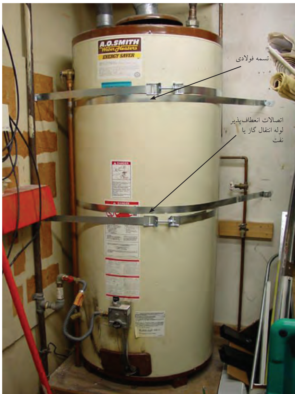
تصویر ۵-۹- نمونه‌ای از نحوه مقاوم‌سازی آبگرمکن
